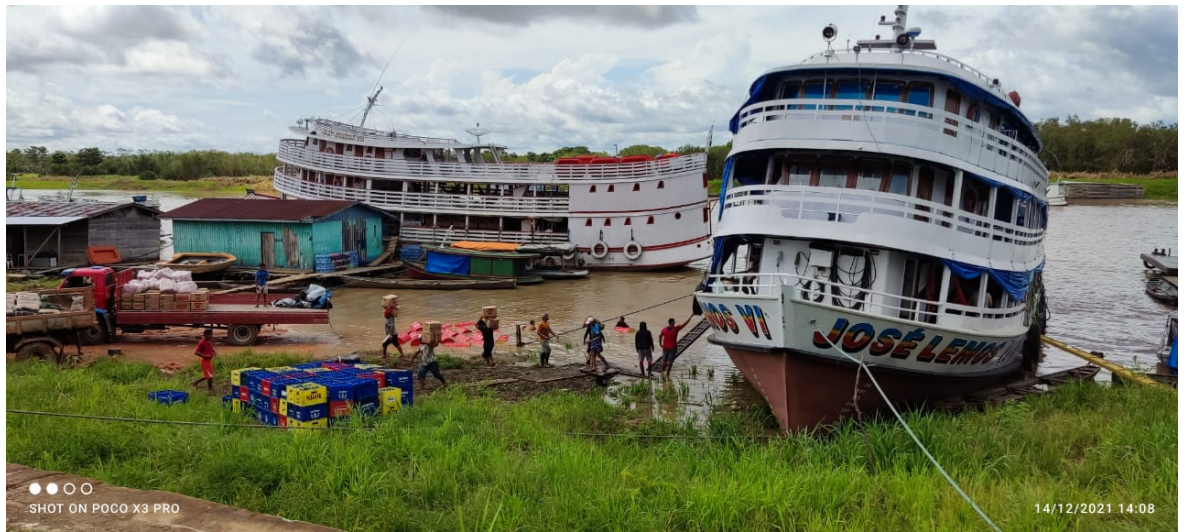
Figura 8. Exemplo de atracação em barranco diante da ausência de estrutura adequada.
