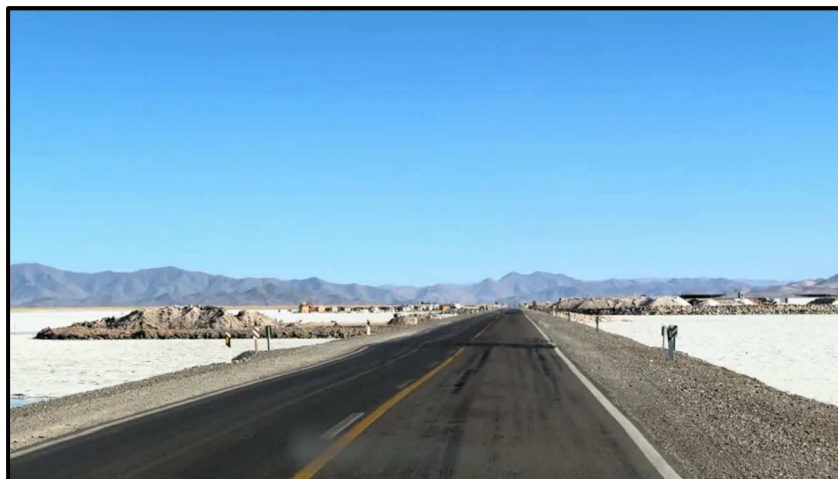
Fig. 42 - Rodovia argentina RN 52, no platô da Cordilheira dos Andes, na região das Salinas antes do Paso de Jama, 03/06/2026
