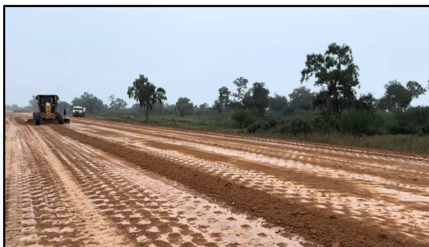
Fig. 22 - Rodovia PY 15 em obras entre Mariscal J. F. Estigarribia e Pozo Hondo em 01/06/2026 - Paraguai
