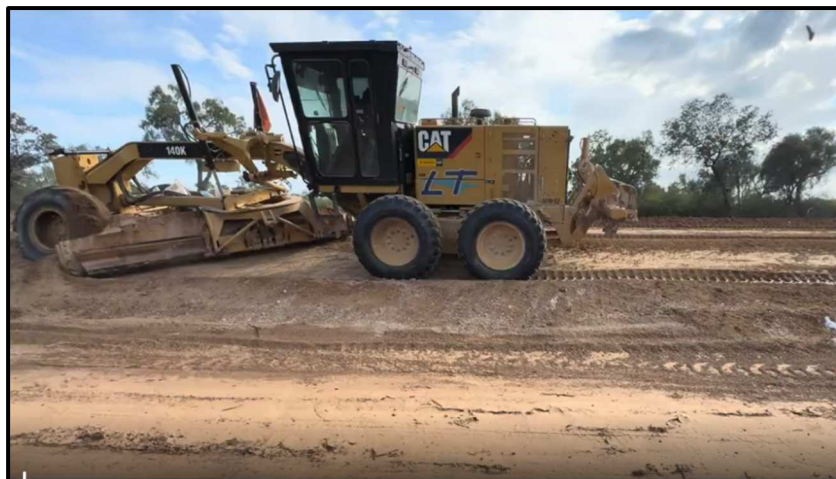
Fig. 21 - Rodovia PY 15 em obras entre Mariscal J. F. Estigarribia e Pozo Hondo em 01/06/2026 - Paraguai
