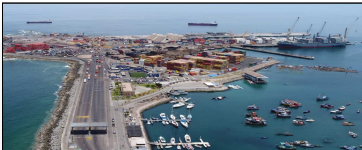
Fig. 72 – Estrutura Portuária no Chile
