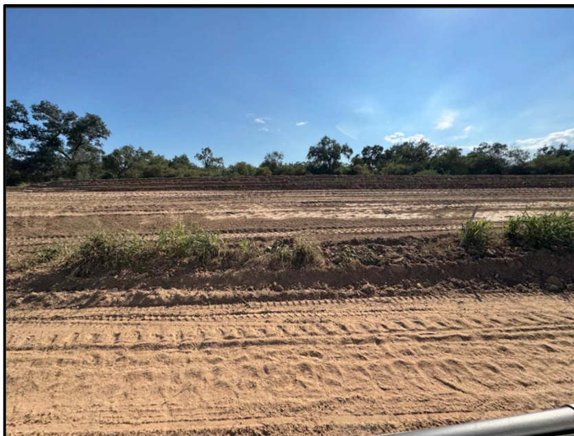
Fig. 18 - Rodovia PY 15 em obras entre Mariscal J. F. Estigarribia e Pozo Hondo em 01/06/2026 - Paraguai
