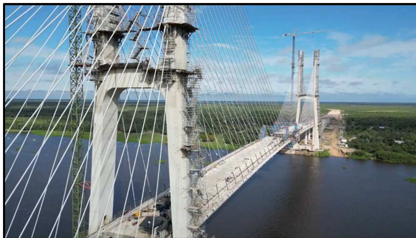
Fig. 09 - Obras da Ponte da Rota Bioceânica - Rio Paraguai entre Porto Murtinho (Brasil) e Carmelo Peralta (Paraguai) em 31/05/2026
