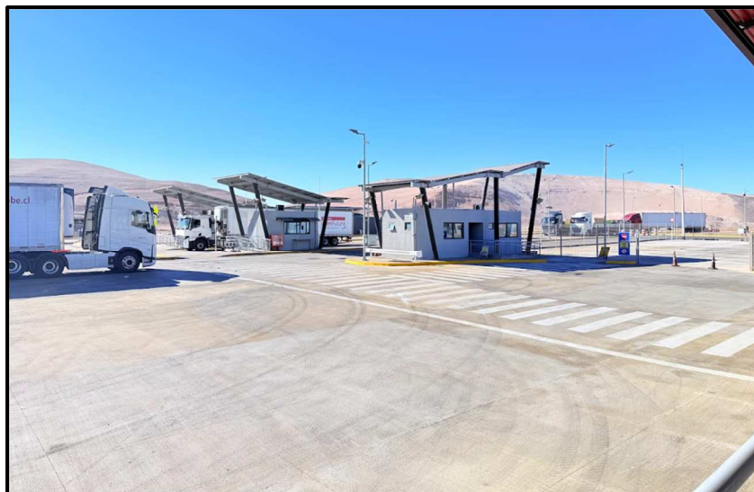
Fig. 57 - Posto de Controle Aduaneiro de Quillagua, a 236 km de Iquique – Chile, Km 1640 da Ruta 5, em 05/06/2026
