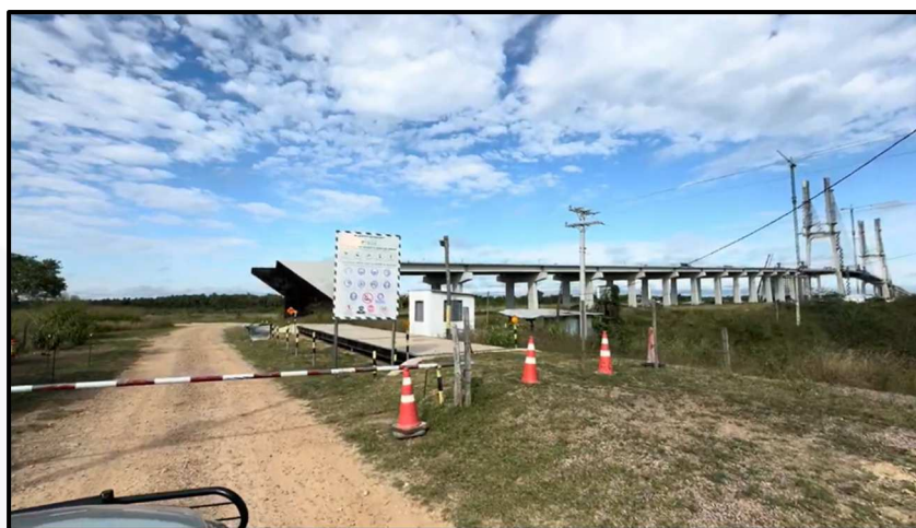
Fig. 07 - Obras da Ponte da Rota Bioceânica - Porto Murtinho (Brasil) em 31/05/2026
