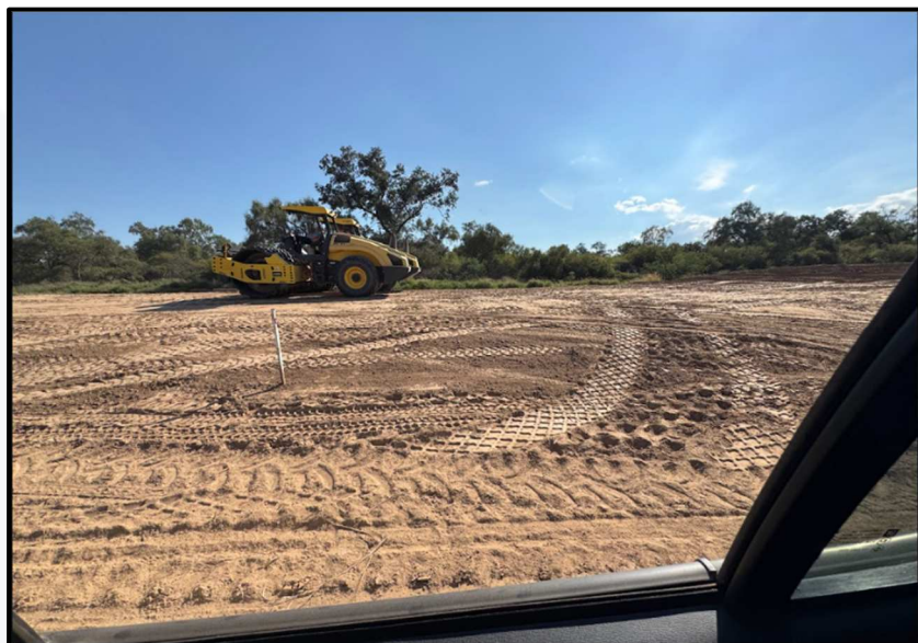
Fig. 19 - Rodovia PY 15 em obras entre Mariscal J. F. Estigarribia e Pozo Hondo em 01/06/2026 - Paraguai
