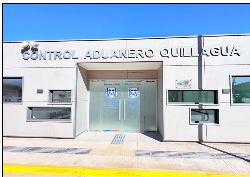
Fig. 58 - Posto de Controle Aduaneiro de Quillagua, a 236 km de Iquique – Chile, Km 1640 da Ruta 5, em 05/06/2026
