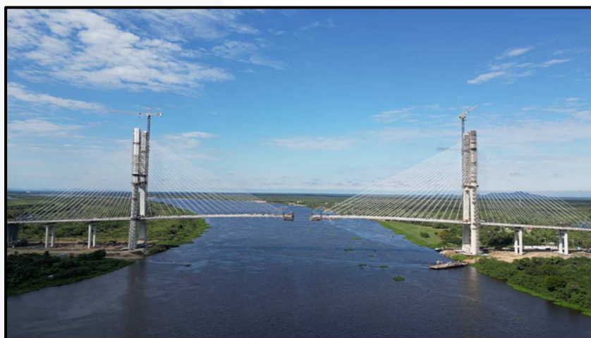
Fig. 08 - Obras da Ponte da Rota Bioceânica - Rio Paraguai entre Porto Murtinho (Brasil) e Carmelo Peralta (Paraguai) em 31/05/2026
