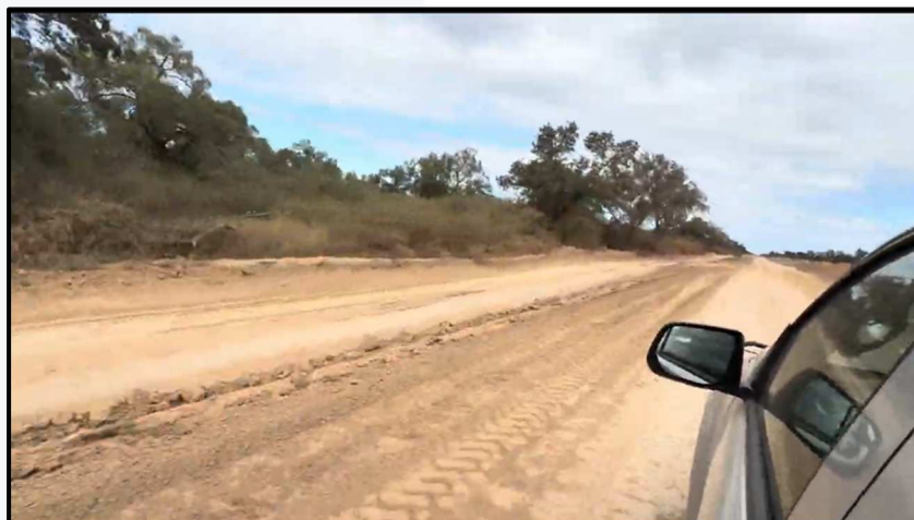
Fig. 20 - Rodovia PY 15 em obras entre Mariscal J. F. Estigarribia e Pozo Hondo em 01/06/2026 - Paraguai
