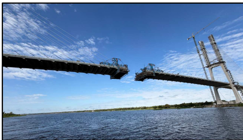
Fig. 10 - Obras da Ponte da Rota Bioceânica - Rio Paraguai entre Porto Murtinho (Brasil) e Carmelo Peralta (Paraguai) em 31/05/2026
