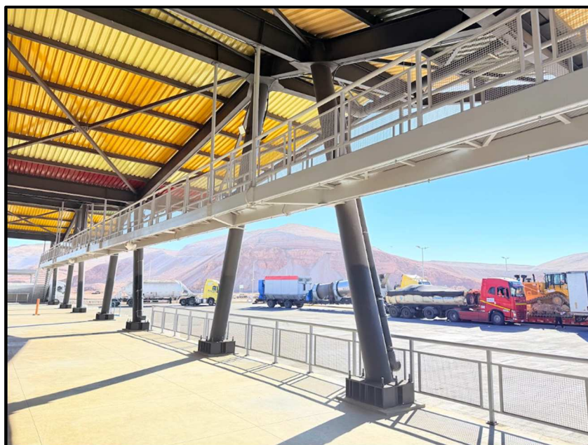
Fig. 59 - Posto de Controle Aduaneiro de Quillagua, a 236 km de Iquique – Chile, Km 1640 da Ruta 5, em 05/06/2026
